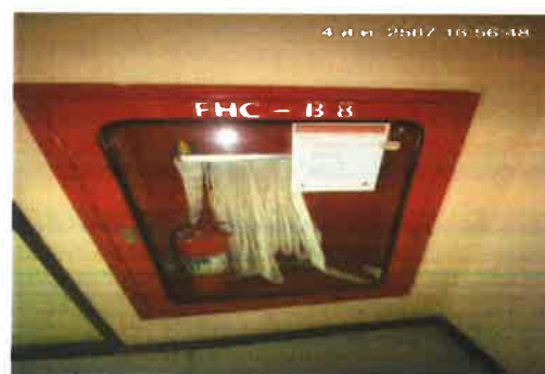
รูปที่ 2.4.6-3 ตู้เก็บสายน้ำดับเพลิงพร้อมอุปกรณ์
