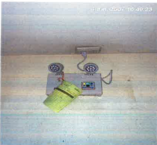
รูปที่ 2.4.5-3 แบตเตอรี่ ขนาด 12V
