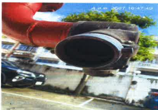
รูปที่ 2.4.6-3 หัวรับน้ำดับเพลิงภายนอกอาคาร
